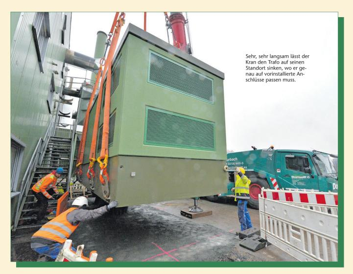
chende Verbraucher die Spannung von 20 kV auf 400 Volt herunter. Denn mit dieser "Niederspannung" arbeiten wiederum sämtliche Maschinen wie die SEO-Sägeanlage oder die Absackanlage der "Westerwälder Holzpellets" ebenso wie die Pelletpressen.
